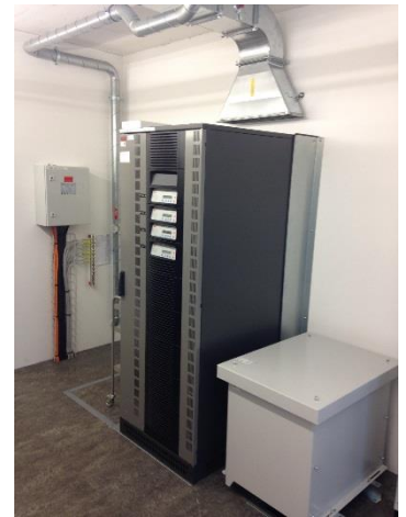
Abbildung 1: Neue ABB-USV 60kVA
